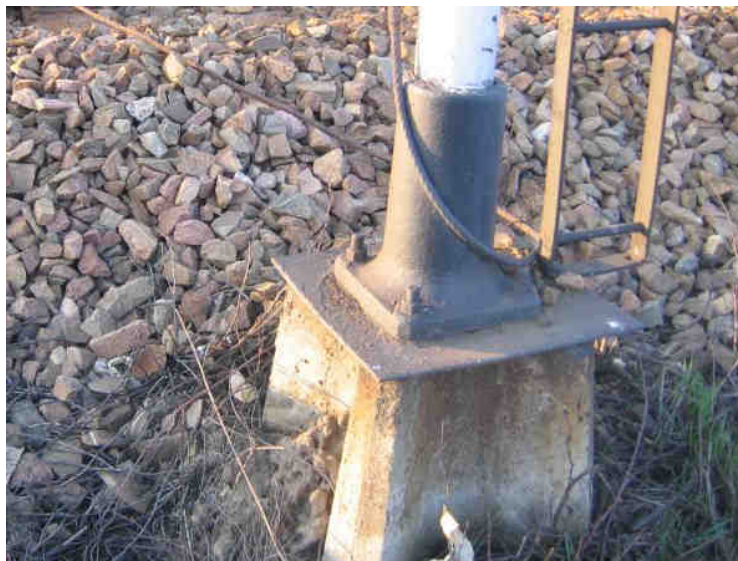
Fundament betonowy sygnalizatora
