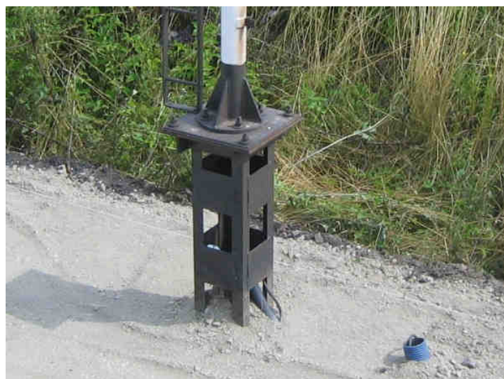
Stalowy fundament sygnalizatora
