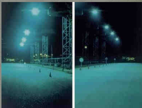
Rys. 4 Dwie sytuacje z oprawami o różnym rozsyle. Po prawej stronie poprawne oświetlenie. Po lewej oprawy o zbyt szerokim rozsyle wywołujące oślnienie u kierowcy.
