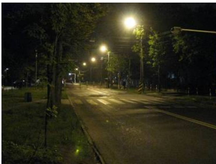
Rys. 4. Zdjęcie ulicy oświetlonej oprawami ulicznymi
