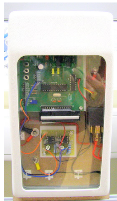
Rys.7. Panel pomiarowy - część tylna z widocznym modulem sterownika i blokiem optoizolatorów.
